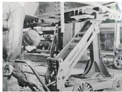
Подъем локомотива домкратом. Паровозное депо станции Болотная, 1940-е гг. Фото из фондов МККУ «Болотнинский районный историко-краеведческий музей»
